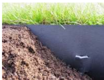
Befestigung mit Stahlanker
